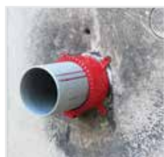
۶- حلقه ضد آتش بر روی دیوار نصب‌شده است.
